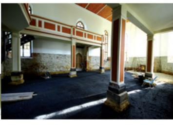
Früher stand hier der Heizkessel, der ja nun nicht mehr nötig ist. Auf diese Weise bekommt Schubkarre tonnenweise Bauschutt aus dem Untergrund entfernt. Zum Zeitpunkt des Verfassens dieser Zeilen steht das Gießen der Bodenplatte aus Beton kurz bevor.
